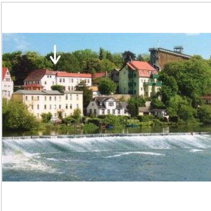
Haus_Ansicht von Brücke mit Pf
