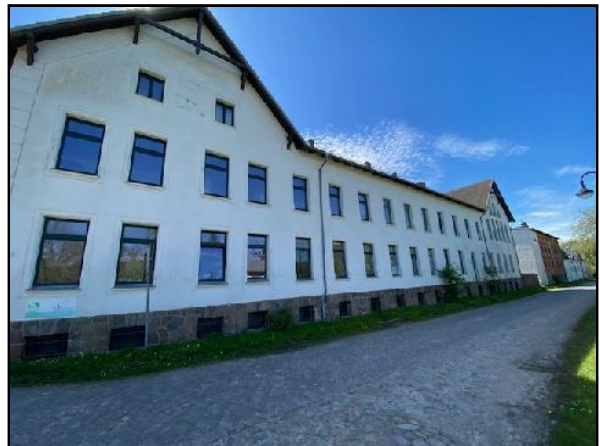
Gebäude 4;5: Straßenansicht Parkstraße
