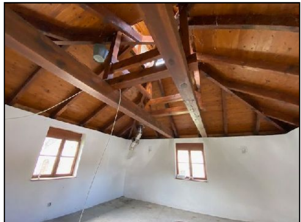
Gebäude 10: Cafe OG
