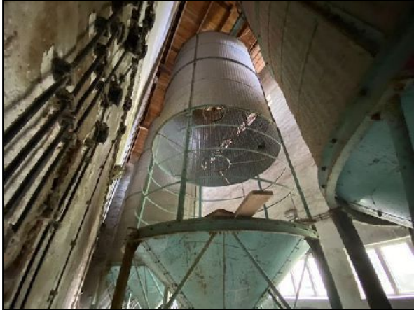
Gebäude 6: Alte Kornspeicher
