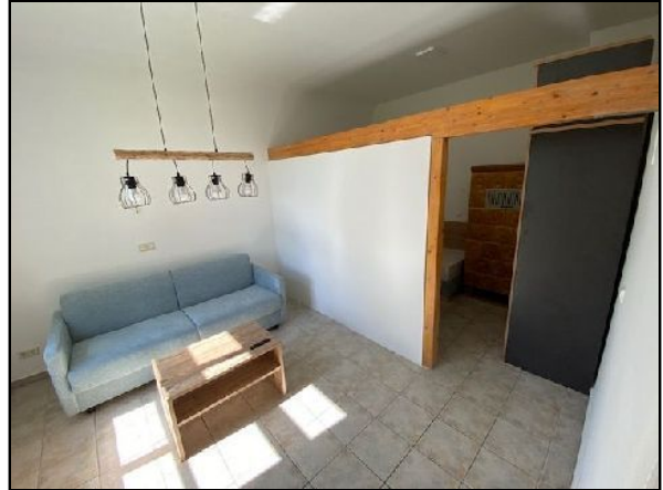
Gebäude 4;5: Renovierte Wohnung
