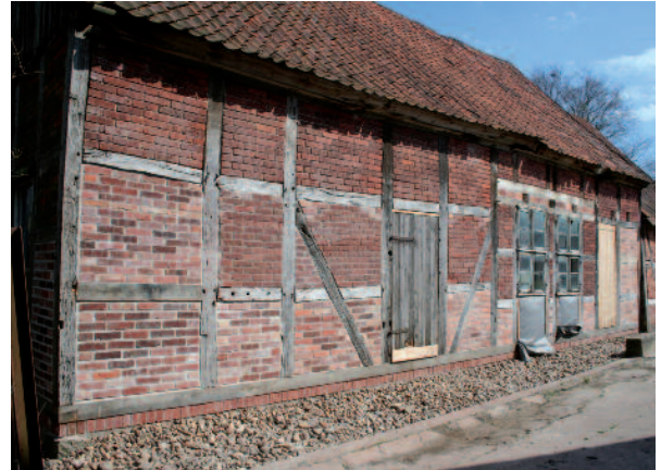
Gebäude nach der Sanierung
