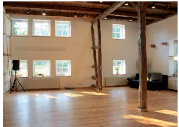
Raum nach Fachwerkrückbau & Renovierung
